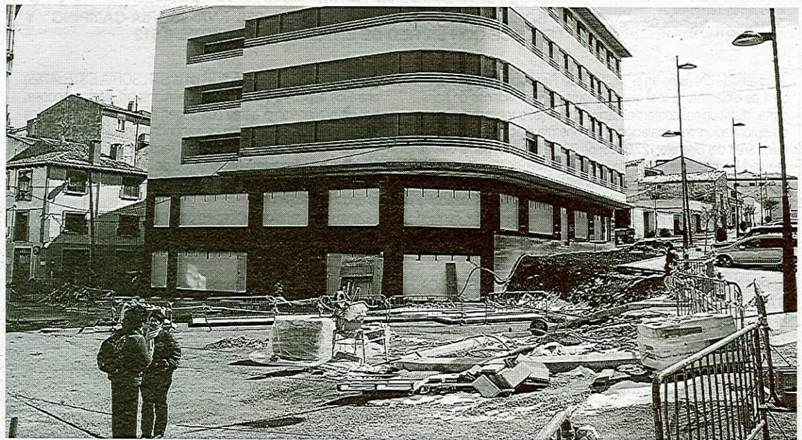
En la imagen, las obras que se desrollan en estos momentos en la localidad. LUIS ÁNGEL TEJEDOR
